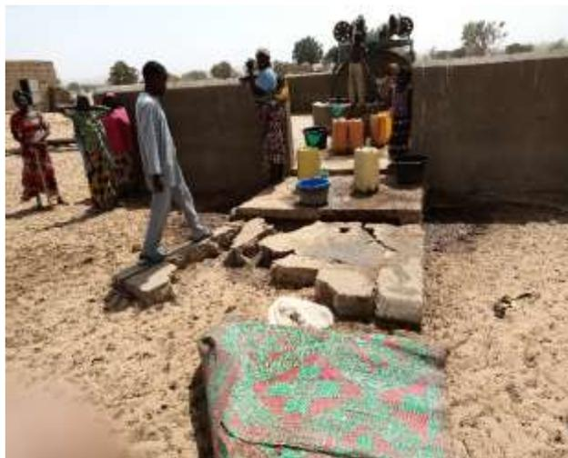
Photo 15 : Mur de protection puits de Makéra effondré
