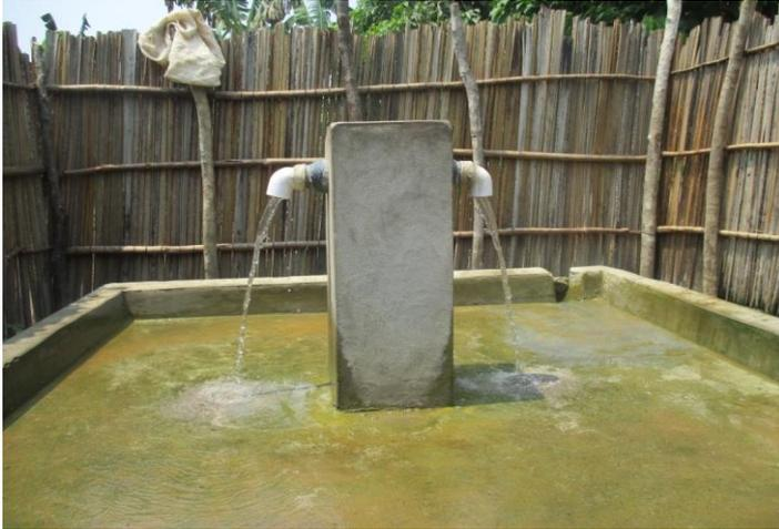
**Photo 10 : forage de Lumbu avec écoulement permanent**
